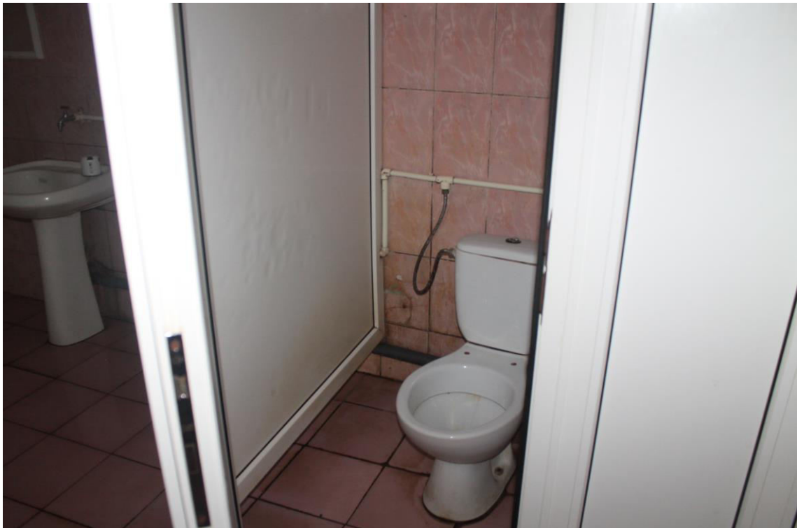
Foto din blocurile sanitare
