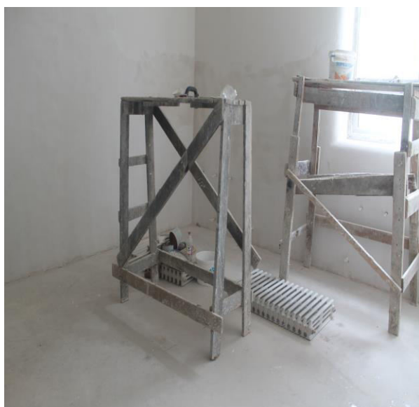
Foto_OAP_izolator în reparație_23.07.2020
