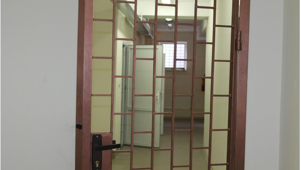
Foto_OAP_acces spre camerele solicitanților de azil_SPF Ocnîța
